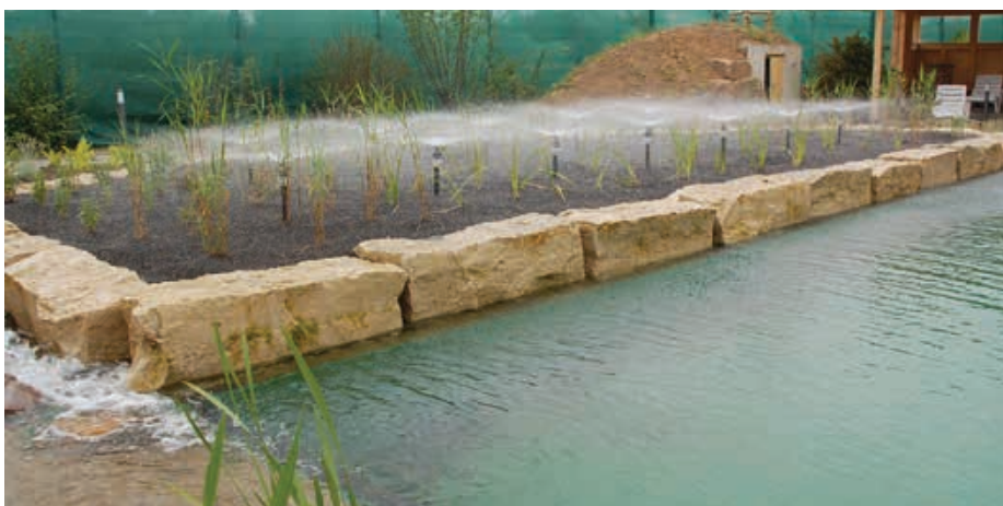
Beregnete Substratfilter. Vor allem hinsichtlich des Keimabbaus sehr leistungsfähig.
